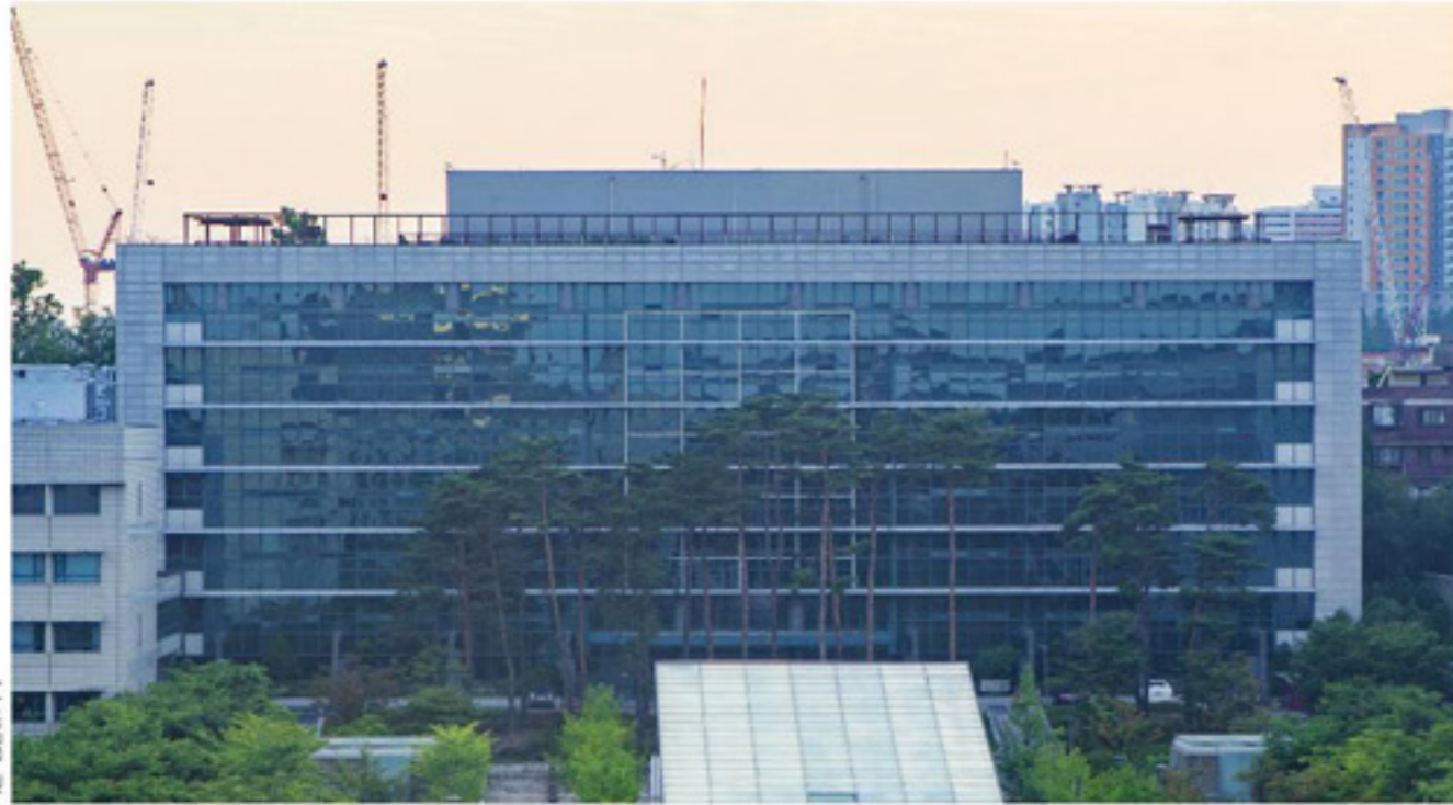
1996년 국내 최초 산학연 종합연구단지인 조성된 테크노컴플렉스 산학관(왼쪽)과 공학관. 단순한 직사각형 건물로 정면 대부분을 유리 커튼월로 덮은 산학관은 당시까지 존재했던 모교 건축물 중 가장 현대적 이미지를 가졌다. T-자형 평면의 공학관은 동서남측 입면의 창에 수평과 수직 차양을 설치한 점이 특징이다.
