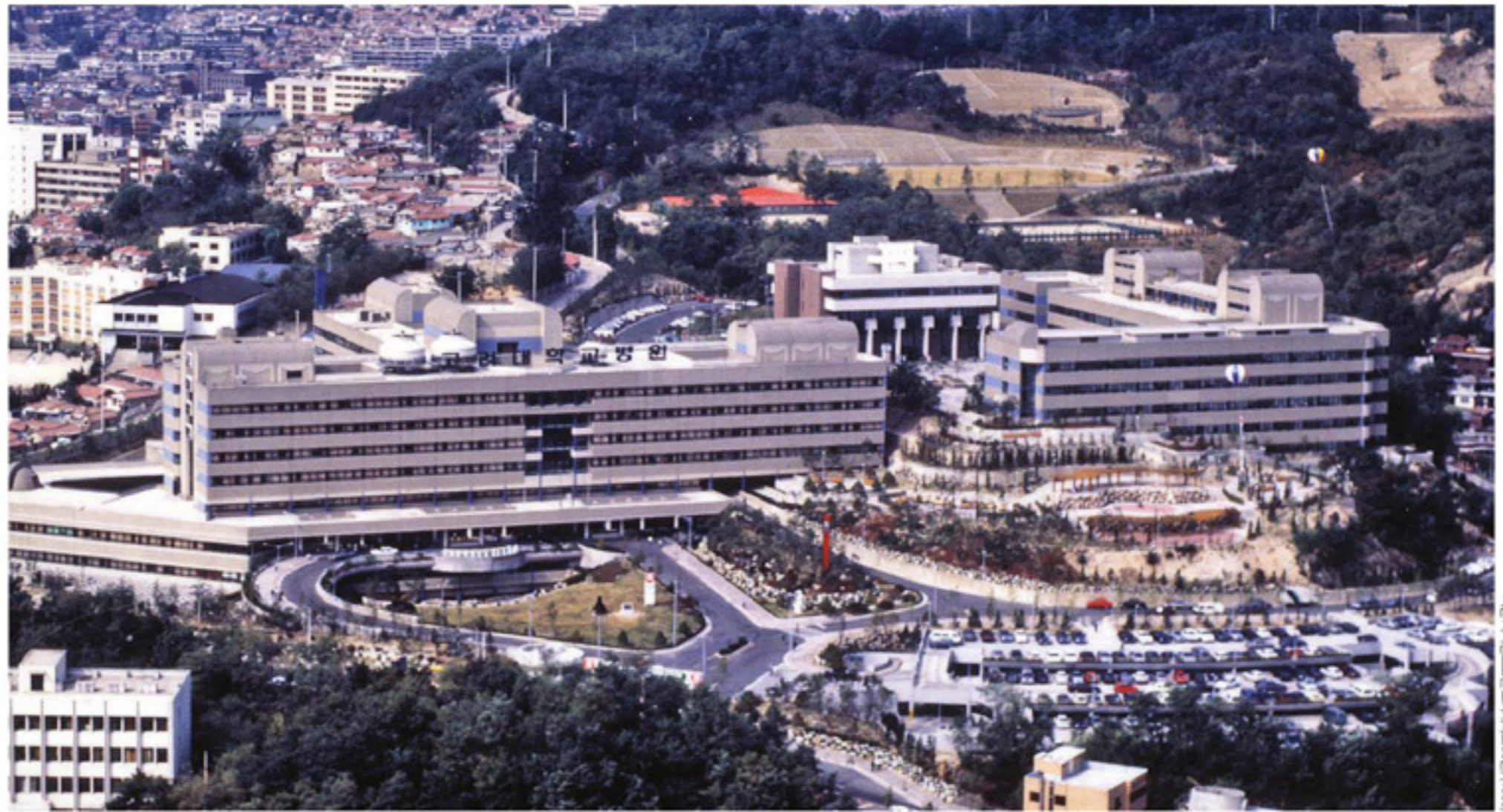
1991년 녹지캠퍼스 1단계 공사로 완공된 안암병원(정면 건물)과 의과대학(오른쪽 건물). 병원과 의대 건물 모두 기다란 매스로 인해 수평성이 강조됐다. 뒤로는 종합운동장 및 노천극장 등의 옥외시설이 보인다.
