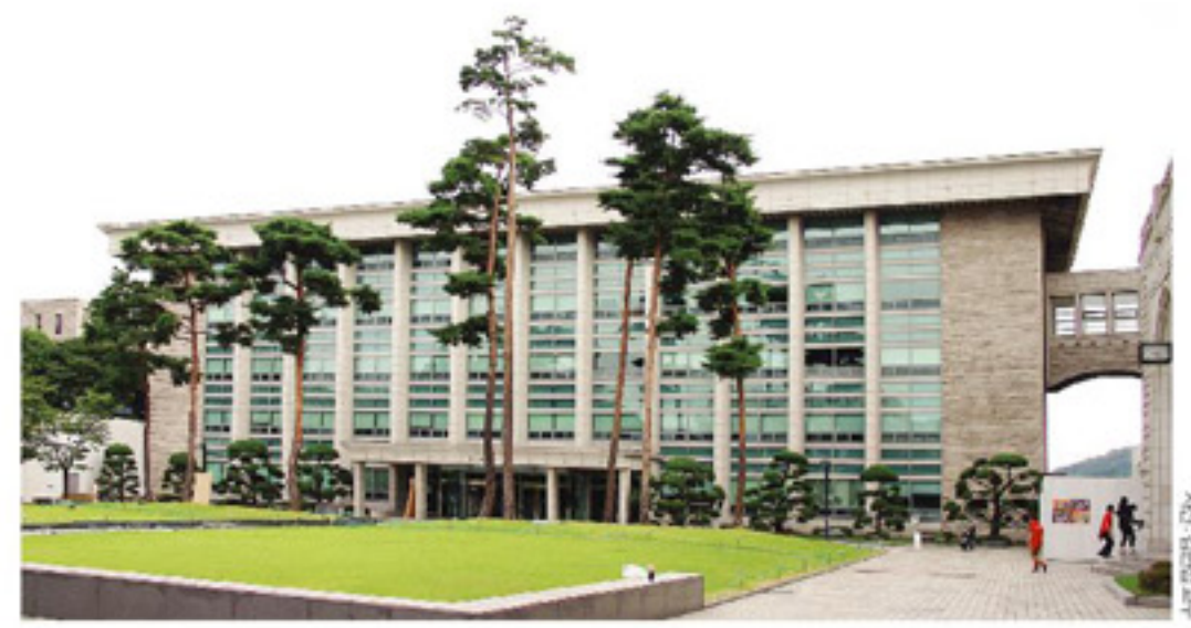
학생회관과 상과대 종합교사는 2000년대에 변형의 계기를 맞는다. 부족한 공간 확보를 위해 수선을 한 현 학생회관(위)은 건물 미관과 다소 어울리지 않는 유리상자를 이고 있고, 리모델링한 현 경영대학 본관(아래)은 세련된 모습으로 거듭났지만, 애초에 선보였던 직선적 조형미는 약화됐다.
