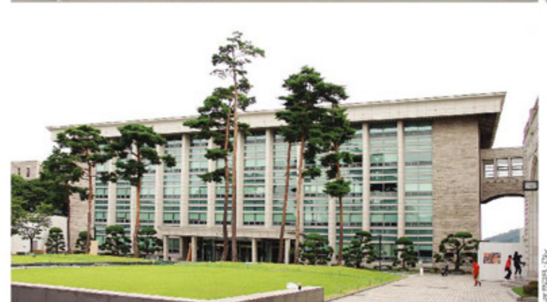
학생회관과 상과대 종합교사는 2000년대에 변형의 계기를 맞는다. 부족한 공간 확보를 위해 수선을 한 현 학생회관(위)은 건물 미관과 다소 어울리지 않는 유리상자를 이고 있고, 리모델링한 현 경영대학 본관(아래)은 세련된 모습으로 거듭났지만, 애초에 선보였던 직선적 조형미는 약화됐다.
