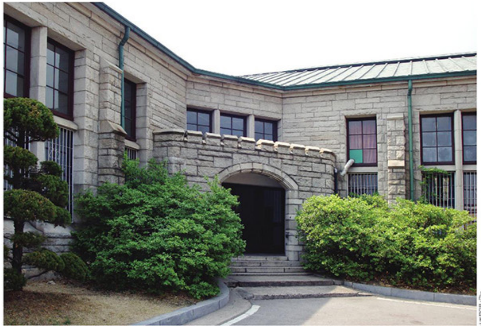
1957년 완공된 신관(현 대강당). 학생수 증가와 대형과목 강의실의 필요를 위해 건축됐다. 단층이지만 강의실이 계단형이라 후면 아래에 부속실을 마련할 수 있었다. 두 날개가 만나는 출입구의 납작한 아치와 상단 여장은 이 건물만의 특징이다.
