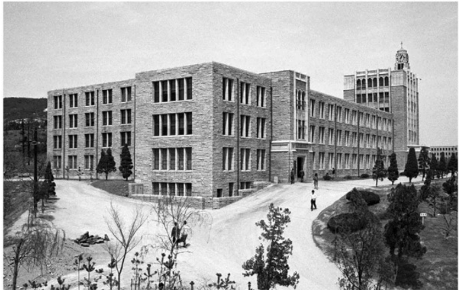
1961년 2단계 완공된 후의 서관. 건너편 도서관의 모습도 일부 보인다. 1992년에도 정면부 증축과 지붕 경사로 공사가 이뤄졌다.
