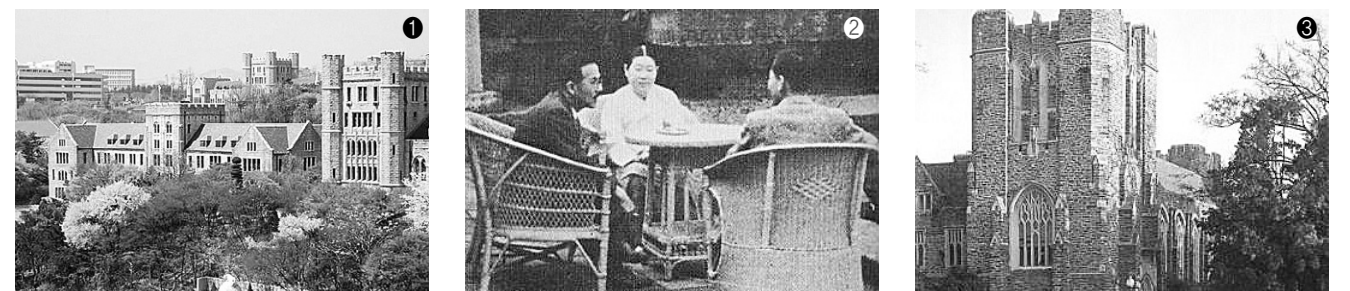
1 안암캠퍼스 본관 (좌: 1934년), 도서관 (우: 1937년) 및 인촌기념관 (후: 1991년). 2 인촌 김성수 선생 내외와 건축가 박동진 3 미국 듀크대 퍼킨스 도서관 (1930년)
