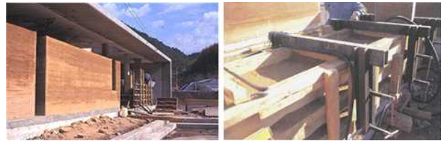
그림 6. 구인현(1999) 흙벽시공 모습 및 흙벽 제작용 담틀 (『정기용 건축 작품집: 1986년부터 2010년까지』, 2011b)
