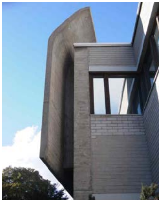
<그림 9> 위바스펠라 경찰서의 방패를 형상화한 보호 외벽, 1967-70
